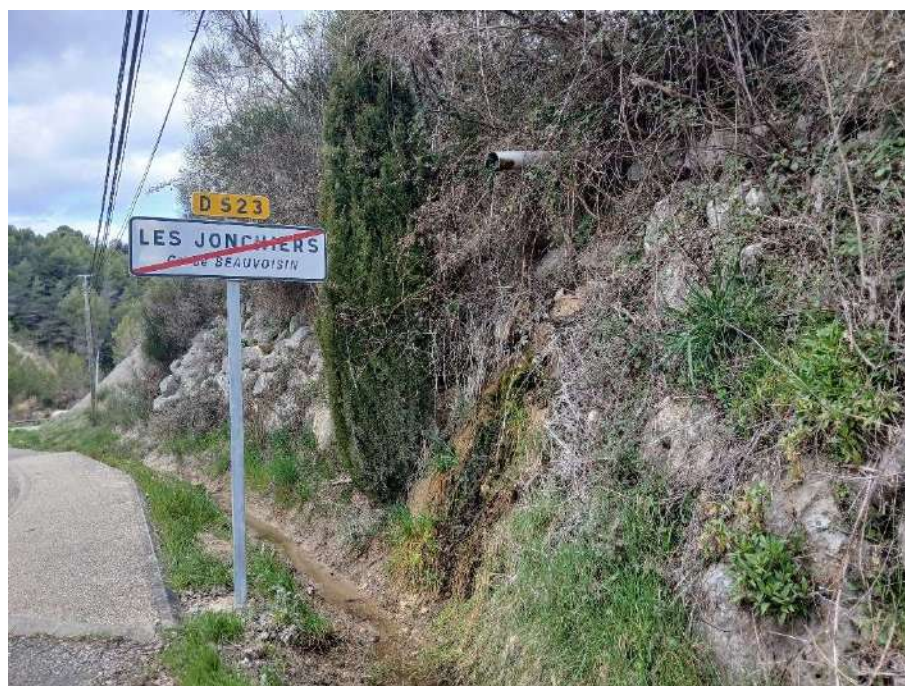
Figure 6 : mur en enrochements confortant le talus amont de la RD523 avec exutoire d'un drain (09/03/2026).
