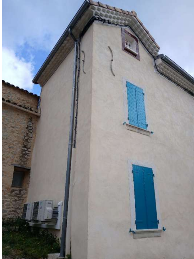
Figure 8 : coin sud-ouest de la maison de la parcelle n°B 376 (09/03/2026).
